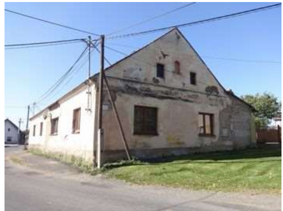
Severovýchodní strana se vstupem na pozemek
