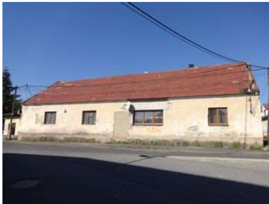
Hlavní průčelí- jihovýchod
