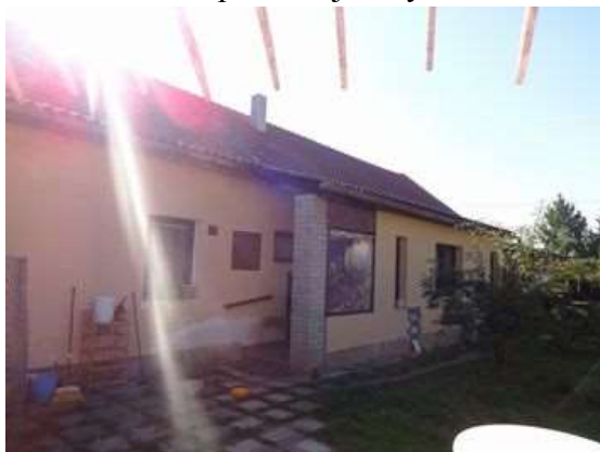
SZ strana - vstup do obytné části, zahrádka
