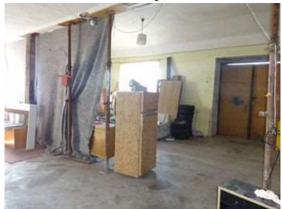
Restaurační sál - podepřený stropní trám
