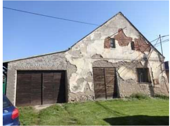
Jihozápadní strana s garáží v přístavbě
