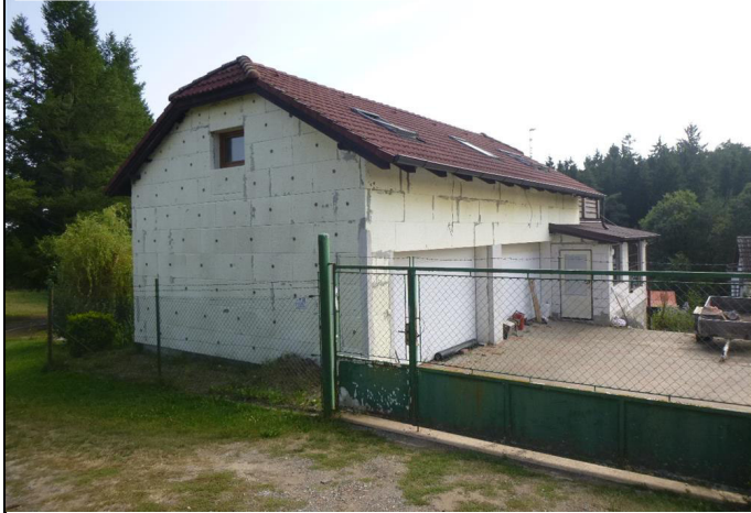
Objekt neevidovaný v KN, na pozemku p.č. 536/1
