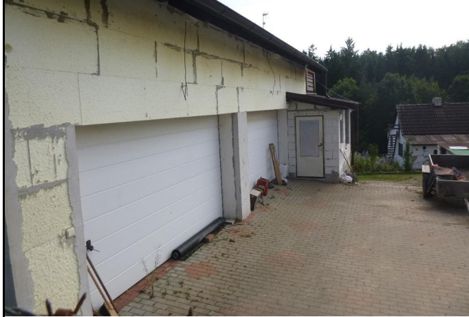
Objekt neevidovaný v KN, na pozemku p.č. 536/1
