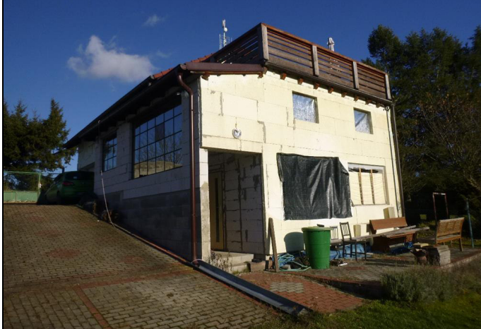
Objekt neevidovaný v KN, na pozemku p.č. 536/1
